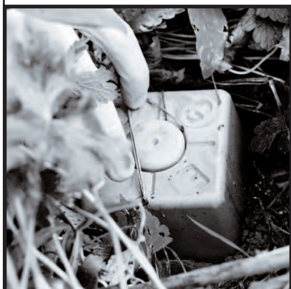
Borne. Lors d'un relevé d'état des lieux, le géomètre recueille un maximum d'éléments de terrain.
